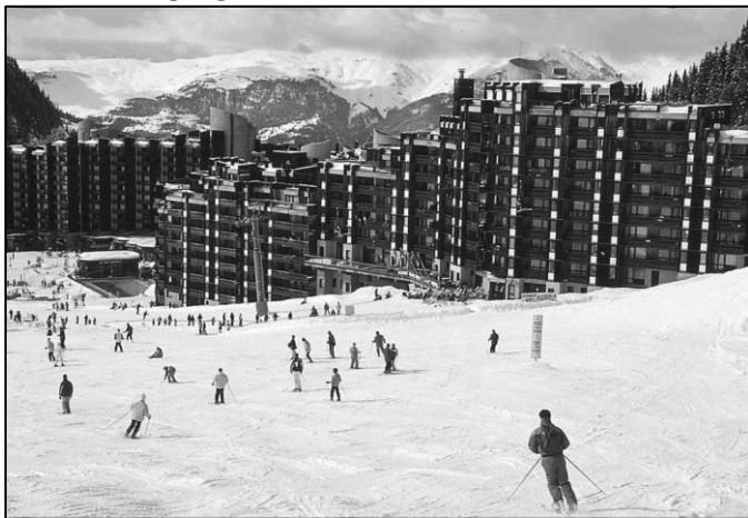
Station de ski de La Plagne (France)
